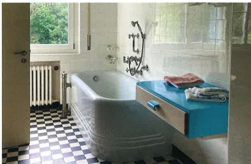
Das Badezimmer mit den knirsch verlegten, also fugenlosen Steinfliesen auf dem Boden und der Wanne mit Doppelwand. Um sie innen zu füllen, gibt es einen zweiten Wasserlauf.
