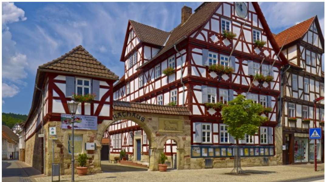
Stattlich und proper: Das Rathaus von Wanfried ist eines der vielen Fachwerkhäuser, die renoviert wurden. (Foto: Hans P. Szyszka/Novarc/mauritus)
